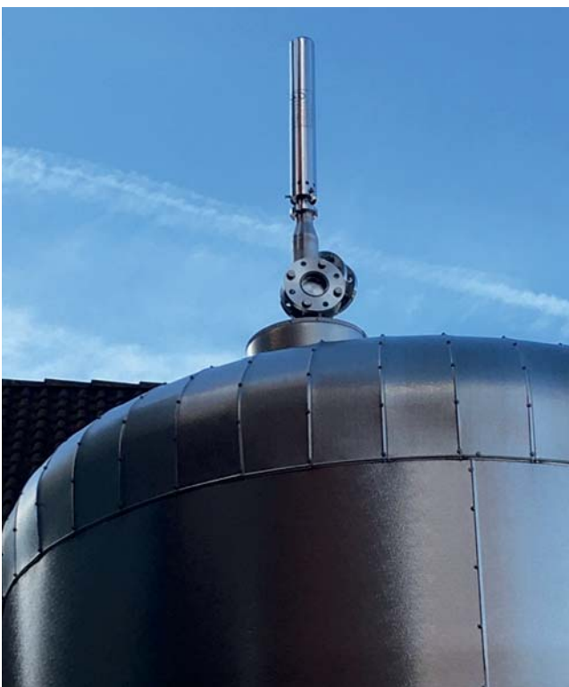
Abb. 4: Der zuverlässige Druckausgleich erfolgt über die LifeTec™ Filterelemente mit denen die Tanks im Außenbereich und in den Produktionshallen ausgestattet sind. Die LifeTec™ PP N Elemente, hier in einem bestehenden Filtergehäuse eingesetzt, erzielen lange Standzeiten. © Graftschafter Krautfabrik
